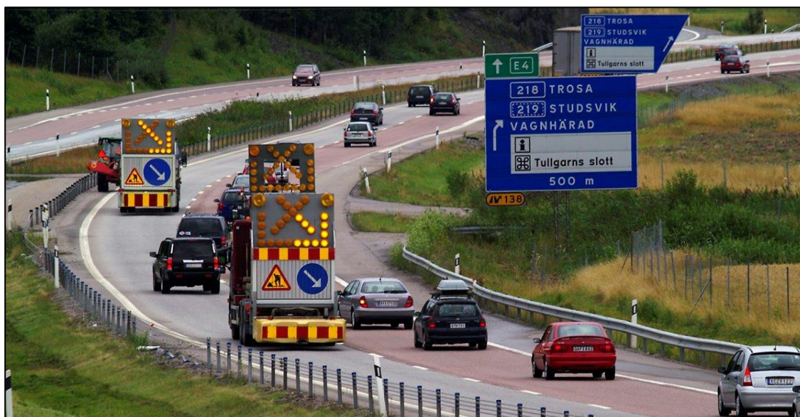
TMA-skydd används vid vägarbete på E4. Foto: Allan Wallberg.
