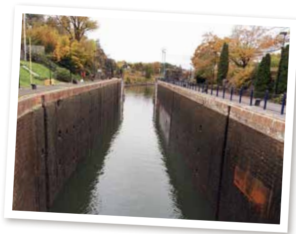
Sluss 2 i Trollhättan. FOTO: TRAFIKVERKET
