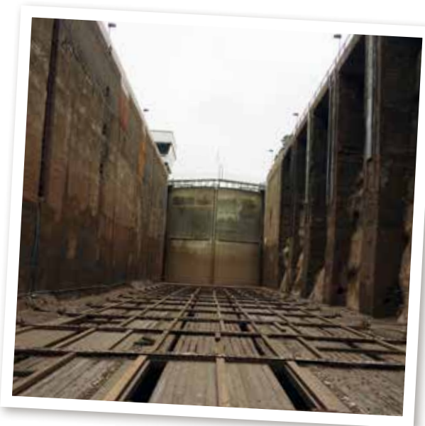
Inifrån en tömd sluss 3, Trollhättan. FOTO: TRAFIKVERKET
