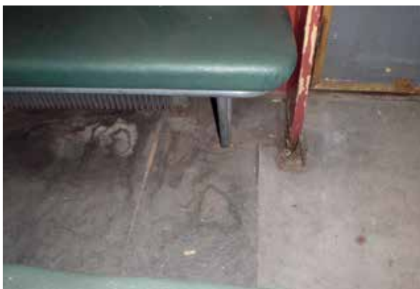
Skador på en av golvmattorna innan restaureringen.
