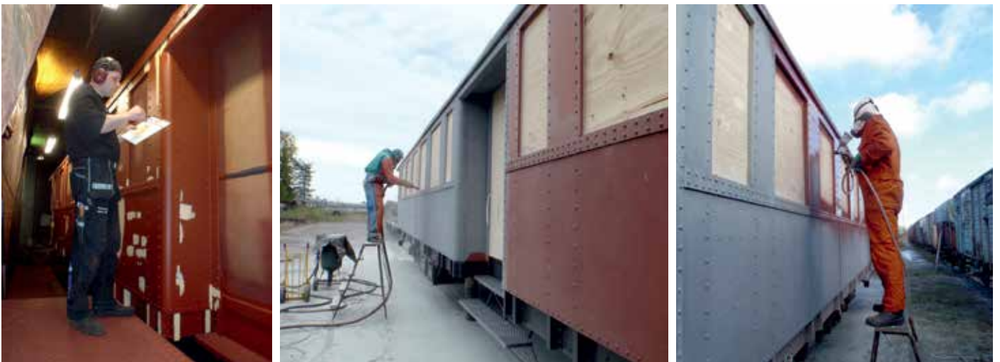
Blästring, spackling och sprutmålning av plåt på korgens utsida, som utfördes av Thomas Lydén.
