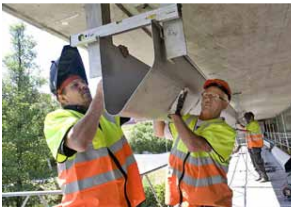
Arbetet med att montera hängrännor som fångar upp förorenat vatten har genomförts på flera broar längs östra Mälaren.
