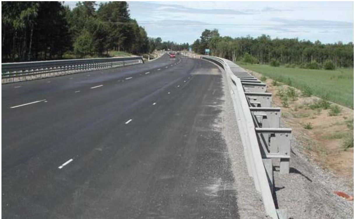
Figur 2. Utförda skyddsåtgärder vid Kinstaby vattentäkt, Söderhamns kommun. Diket har tätats med sandbentonit och skyddas av högkapacitetsräcken (foto: Lena Blad).
