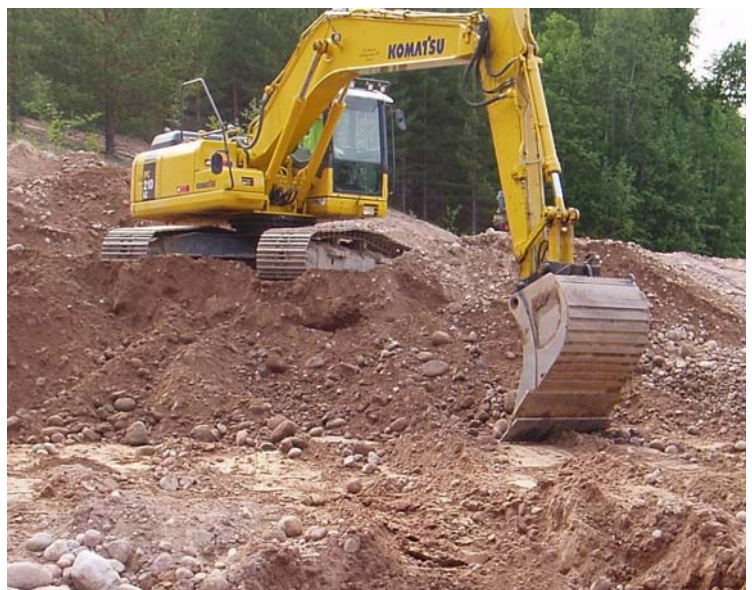
Figur 4. Bortgrävning av förorenade massor i den omättade zonen.
